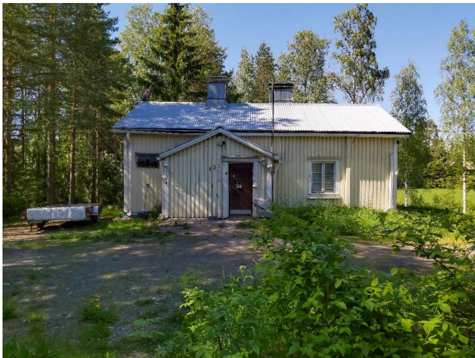
Kuva rakennuksesta katuosoitteessa Virtalantie 131
